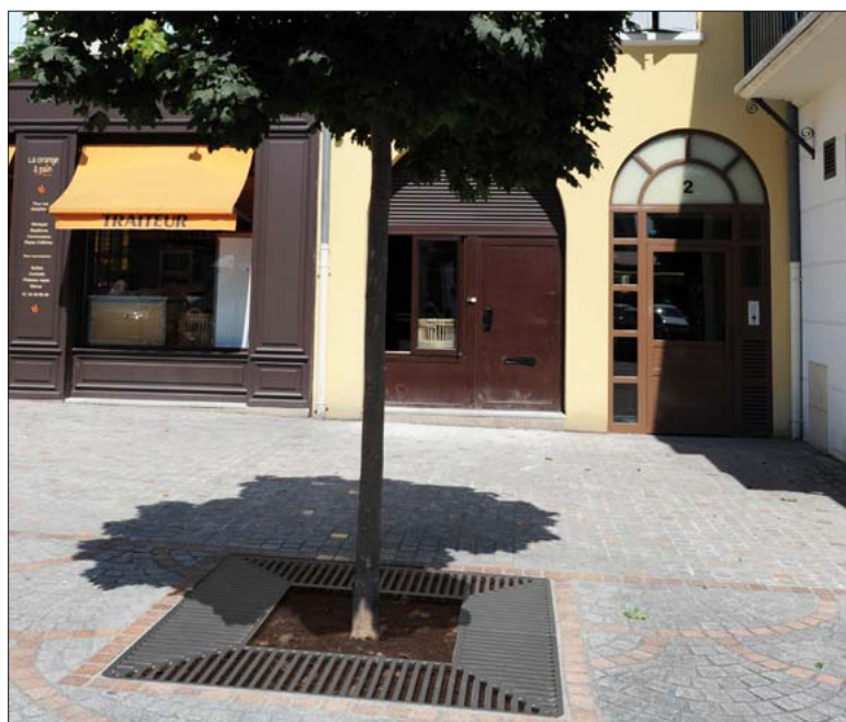
Baumschutzrost rechteckig, Ausführung verzinkt + beschichtet RAL 9005 tiefschwarz
